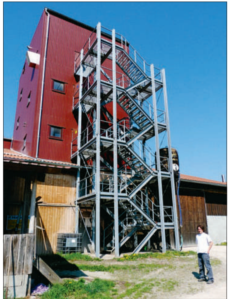
Die Soja-Aufbereitungsanlage auf dem Asamhof ist ausgelastet. Hier werden etwa 1500 t Sojabohnen und rund 1500 t Erbsen, Ackerbohnen und andere Futtermittel verarbeitet.
